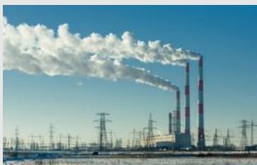
Centrali di cogenerazione / trigenerazione
