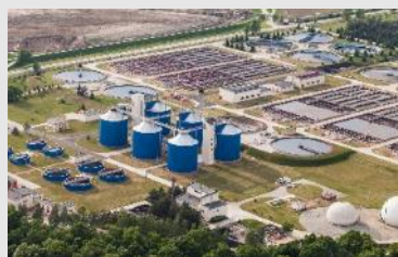
Centrali da trattamento rifiuti
